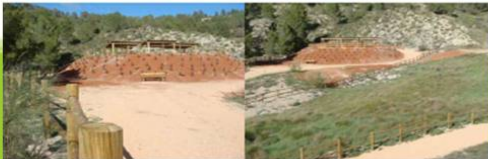
Dos vistas de los trabajos de revegetación en El Salobral, Enguadano (Cuenca)
